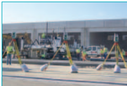
Deux théodolites visent en continu les prismes de 360° installés sur la machine et le troisième sert à vérifier les mesures et à avancer sur les grandes distances.
