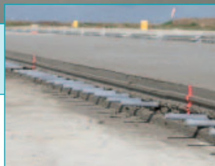
des géomètres, avec en plus la casquette d'informaticiens de chantier”.
