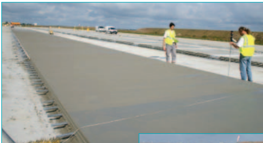
Le guidage 3D permet d'avoir des bandes très nettes et régulières. À droite : la dalle de 40 cm d'épaisseur, avec ses couches de béton maigre et de béton de roulement marquées tous les 5 mètres.
